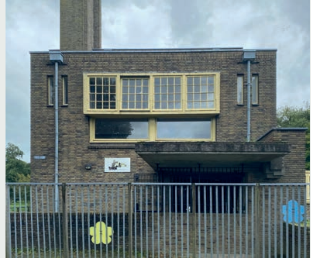
situatie voor renovatie
